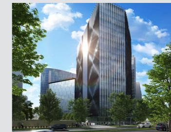
Caso fachada con paneles fotovoltaicos - Edificio Nueva Córdoba Las Condes, Santiago 50.000 m2 construidos aprox Empresa: SENCORP Año: 2017 Link(s) de interés: https://nuevacordova.cl
