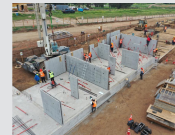
Caso Sistema industrial de construcción robotizada de hormigón armado - Baumax Link(s) de interés: www.baumax.cl
